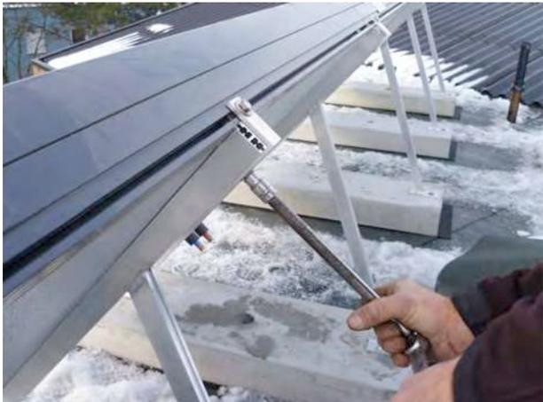
Aluwinkel in die Montageprofile mit Gleitmuttern befestigen.
