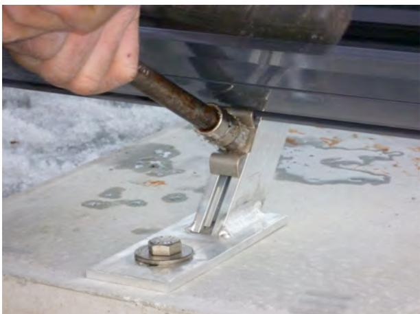
Die Klammern in die Nut einhängen und fixieren.
