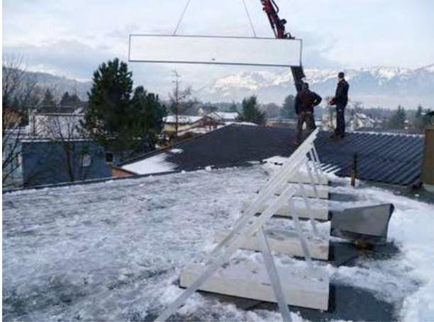
Kollektor mit dem Kran auf das Dach heben.
