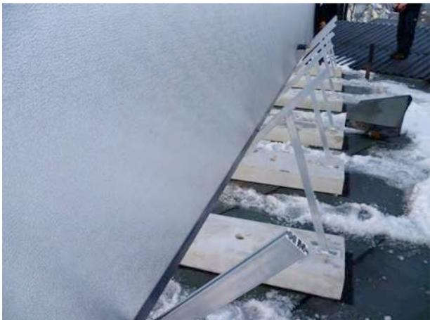
Den Kollektor in der mitte der Aufständering ansetzen und langsam auf die Klammern nach unten gleiten lassen.
