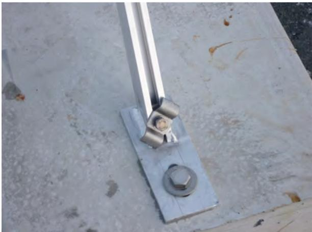
Die Klammern bis an das Ende der Montageschiene fallen lassen.
