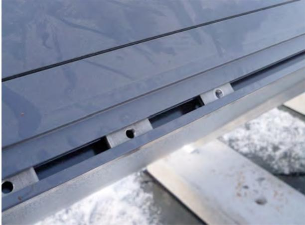
Gleitmuttern auf die Gestelle durch verschieben verteilen.
